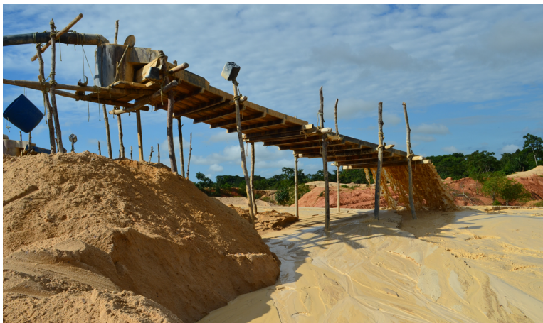
Figura 13. Calha inclinada: concentração gravimétrica de ouro secundário em lavra a céu aberto
